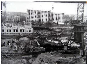
Будівництво корпусів ССГІ 90-ті рр. XX ст..
